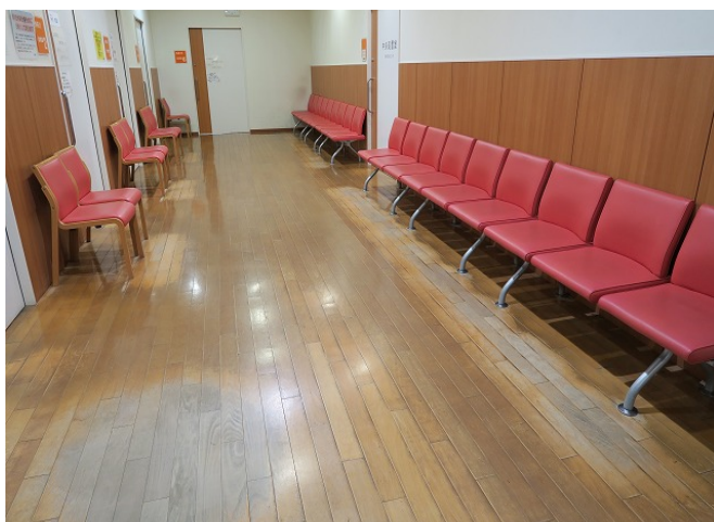
【図表－9】 外来待合(中待合)フローリングの劣化状態
