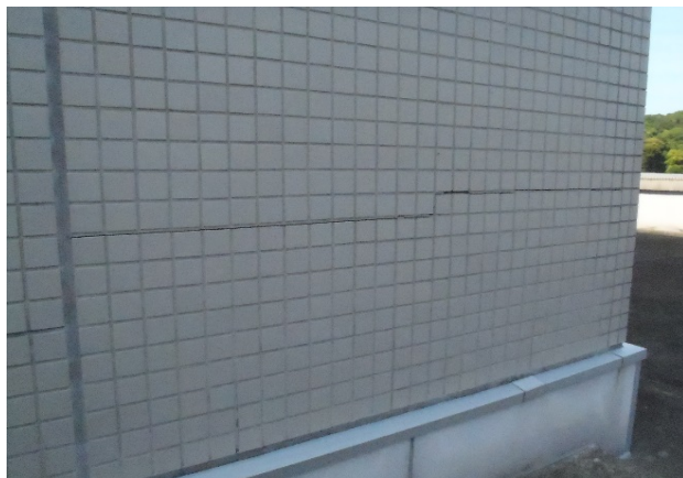
【図表－8】 外壁タイルの劣化状態
